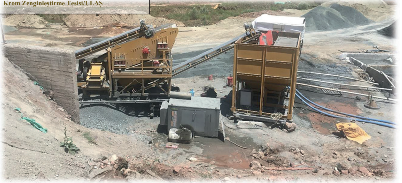
Krom Zenginleştirme Tesisi/ULAS
