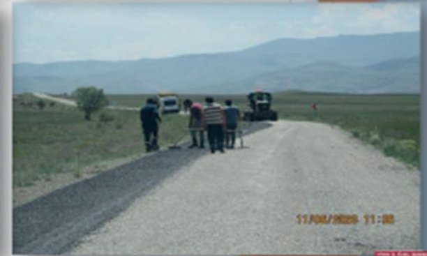
II.KAT ASFALT YAMA ÇALIŞMALARI
