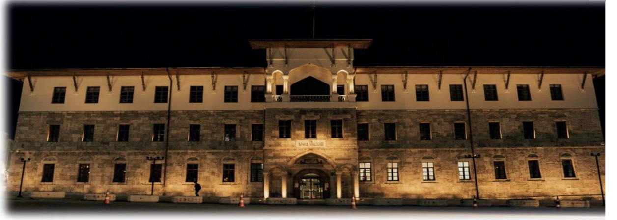
Sivas Tarihi Hükümet Konağı Dış Cephe Aydınlatma)
