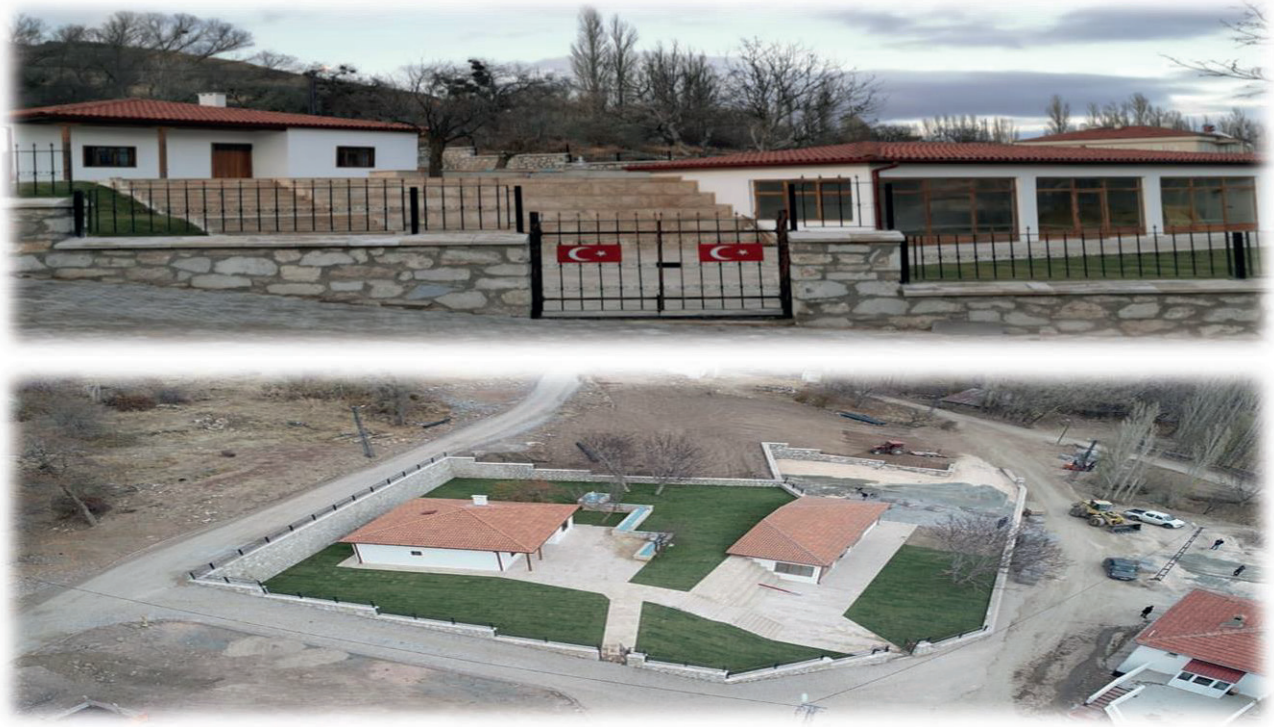
Muhsin Yazıcıoğlu Evi Restorasyon Sonrası Görünümü
