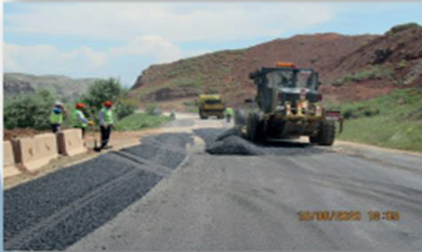
II.KAT ASFALT YAMA ÇALIŞMALARI
