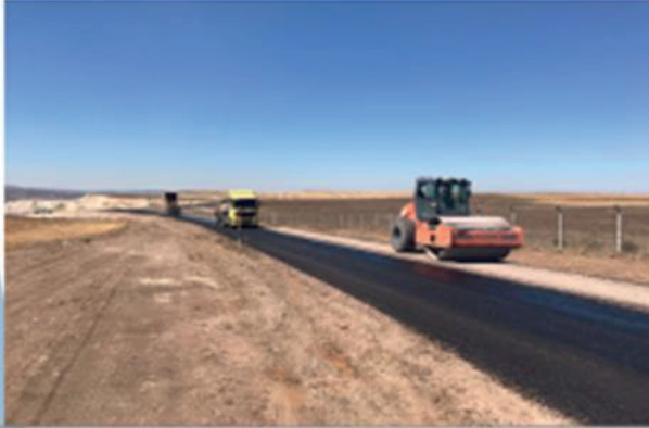
I.KAT ASFALT KAPLAMA ÇALIŞMALARI
