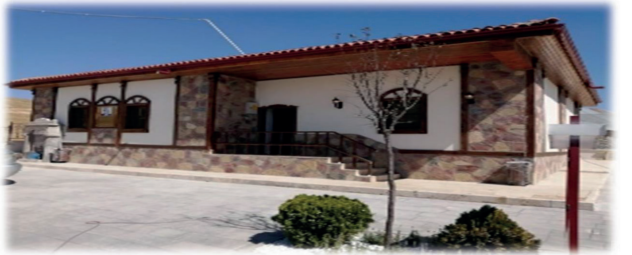
Kangal Deliktaş Köyü Aşık Ruhsati Evi Onarım İşi
