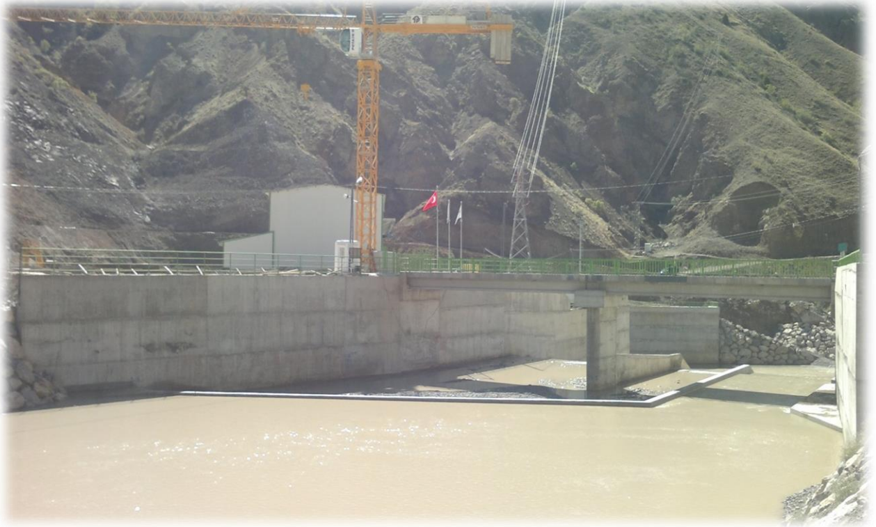
Hidroelektrik Santralı Göllüce Köyü / Akıncılar
