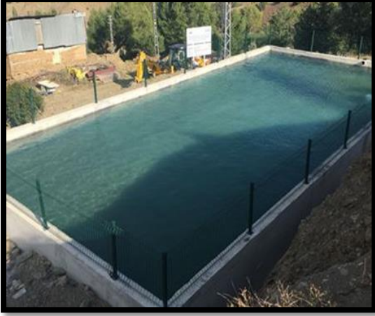
İmranlı Yoncabayırı havuz inşaatı (180 m3)
