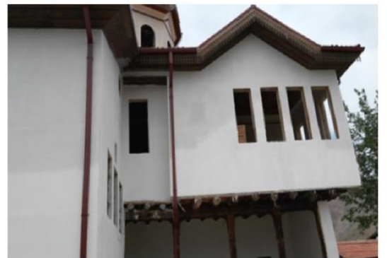
Tevrüzlü Konağı Restorasyon Sırasında Görünümü
