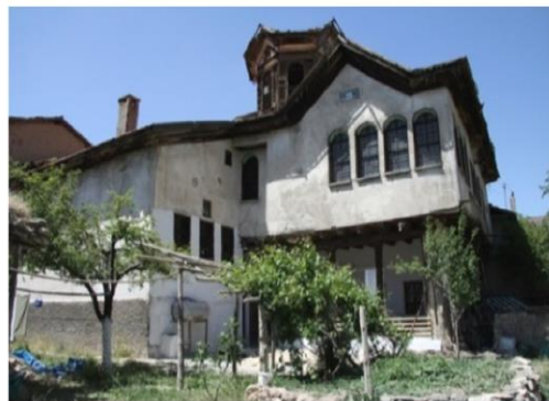
Tevrüzlü Konağı Restorasyon Öncesi Görünümü
