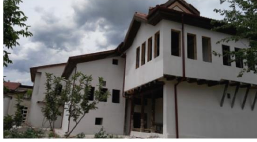
Tevrüzlü Konağı Restorasyon Sırasında Görünümü
