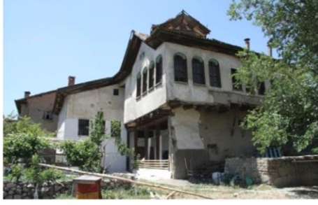
Tevrüzlü Konağı Restorasyon Öncesi Görünümü
