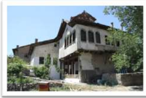
Tevrüzlü Konağı Restorasyon Öncesi Görünümü
