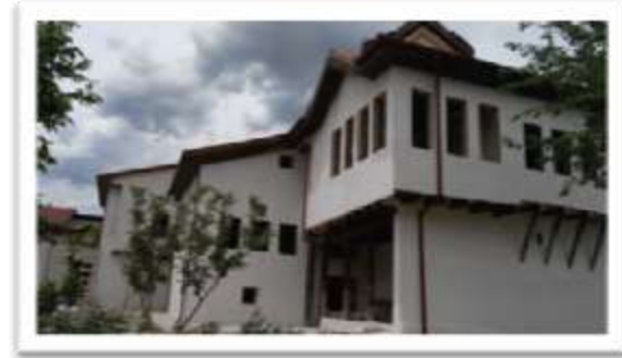
Tevrüzlü Konağı Restorasyon Sırasında Görünümü
