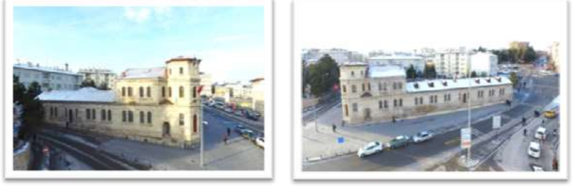
Jandarma Binası Görünümü
