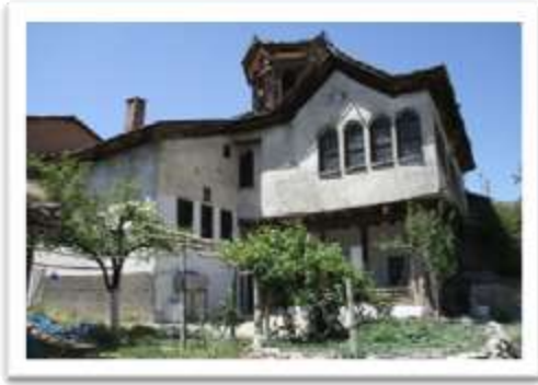
Tevrüzlü Konağı Restorasyon Öncesi Görünümü
