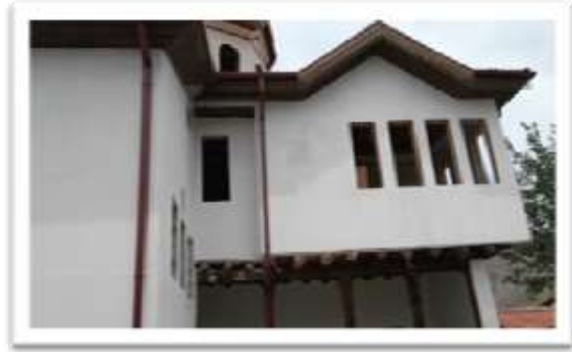
Tevrüzlü Konağı Restorasyon Sırasında Görünümü
