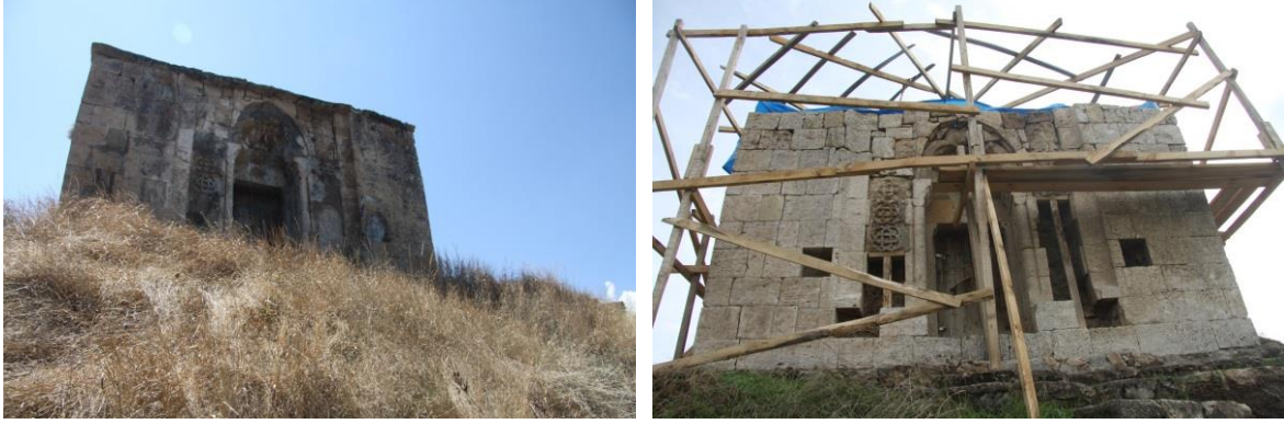
Çobanbaba Türbesi (Restorasyon Öncesi ve Sırasında)
