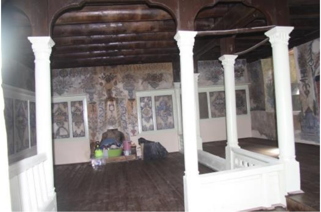
Sögütçük Köyü Konuk Odası ( Restorasyon öncesi ve sonrasında)
