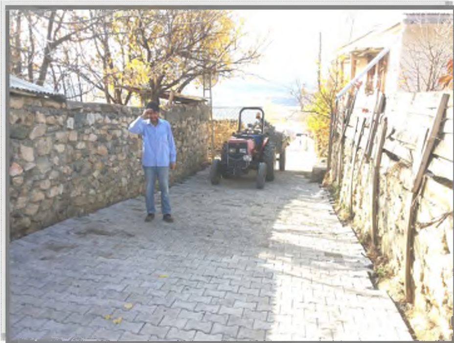
GÖLOVA İLÇESİ BOZAT KÖYÜ KİLİTLİ PARKE ÇALIŞMALAR
