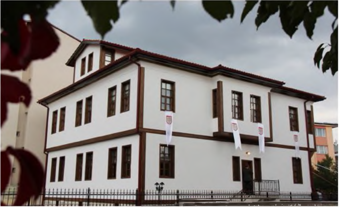
Şükriye Özçalı Konağı (Restorasyon Sonrası)
