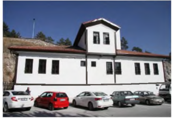
(Basit Onarım Sonrasında)
