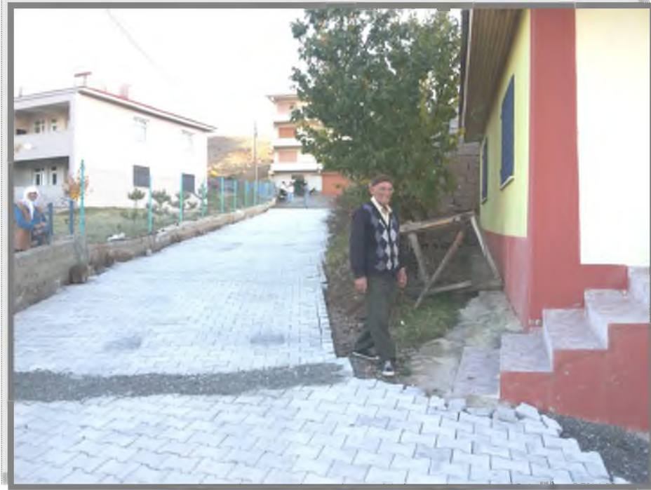
GÖLOVA İLÇESİ GÜNALAN KÖYÜ KİLİTLİ PARKE ÇALIŞMALARI
