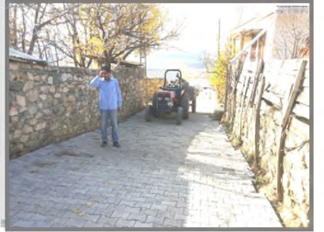
GÖLOVA İLÇESİ BOZAT KÖYÜ KİLİTLİ PARKE ÇALIŞMASI
