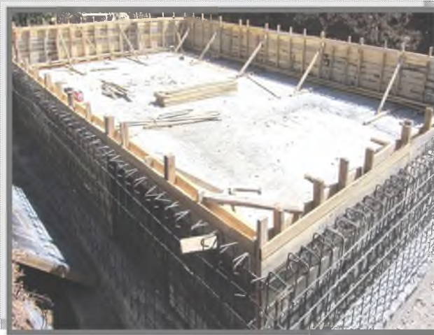
SUŞEHİRİ İLÇESİ YEŞİLYAYLA KÖYÜ SULAMA HAVUZU İNŞAATI
