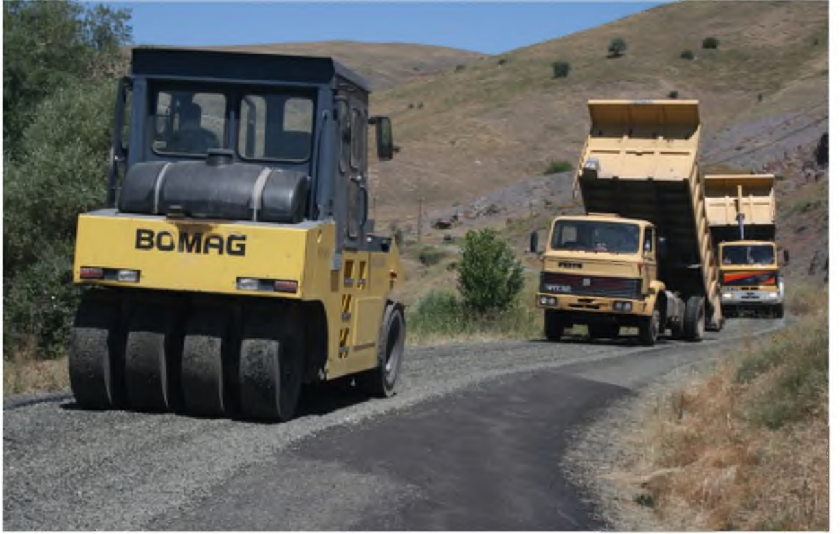
Asfalt sathi kaplama alıřmaları
