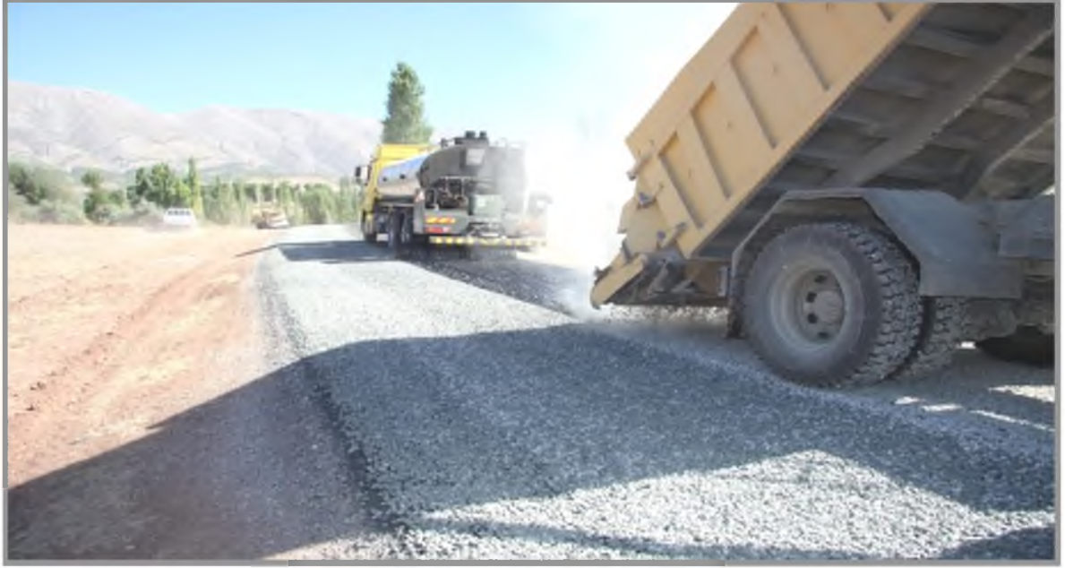
ULAŞ İLÇESİ KAYAPINAR KÖYÜ ASFALT ÇALIŞMASI
