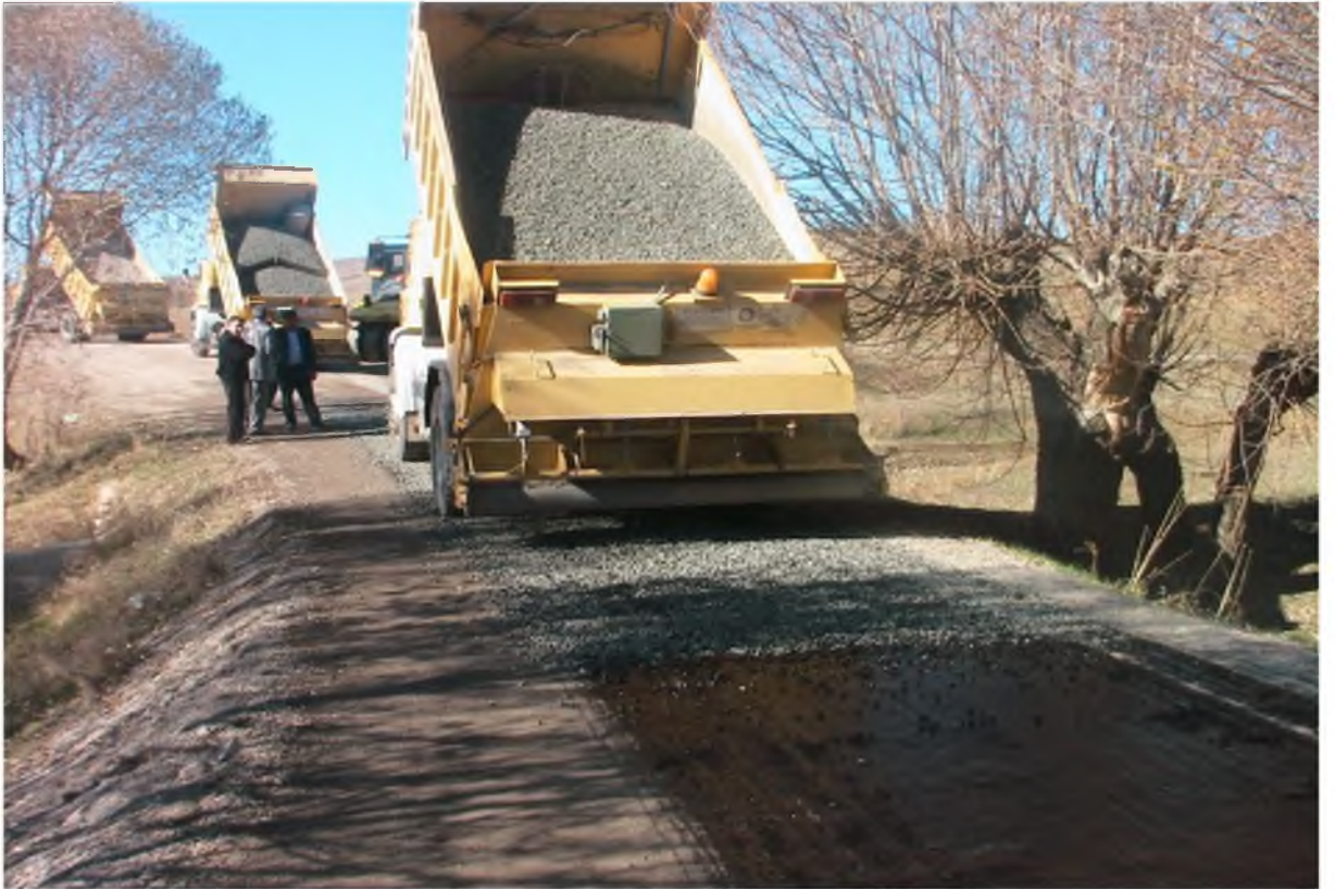
Asfalt sathi kaplama alıřmaları
