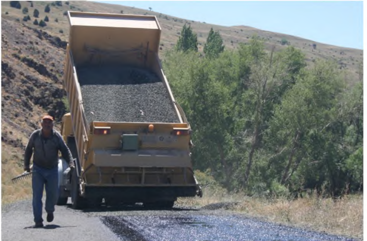
Asfalt sathi kaplama çalışmaları
