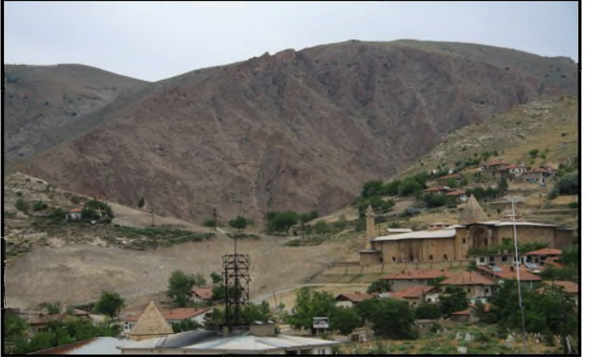
Divriği Ulu Camii Çevresi Yıkım Çalışmalarından Sonraki Hâlihazır Görüntüsü
